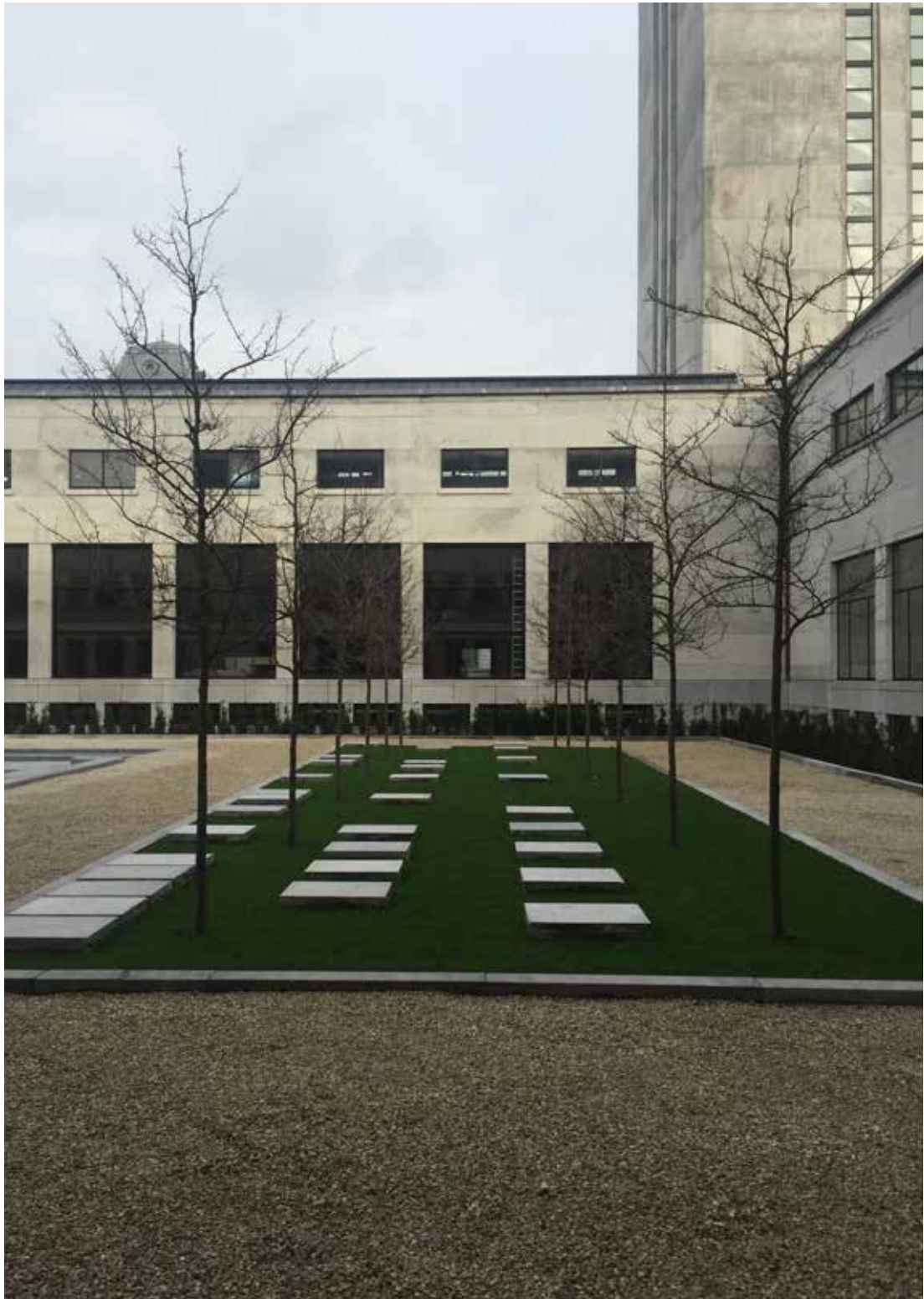
© Robbrecht en Daem architecten - Opvolging werf Boekentoren fase 2B - 3 incl. ontwerp en realisatie installatie binnentuin
